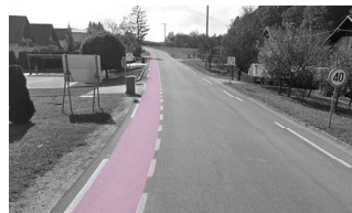
Slika 16: Pas za pešce na vozišču profila Zgornja Velika: Pas za pešce na obstoječem vozišču je mogoče izvesti le, če so izpolnjeni naslednji pogoji: dovoljena hitrost ne presega 30 km/h in povprečni letni dnevni promet (PLDP) je manjši od 2500 vozil na dan. Na obravnavanem odseku ustreza omejitev hitrosti ni zagotovljena. Glede na vzdolžni profil ceste in pričakovane hitrosti vožnje je odsek za pešce potencialno nevaren, zato se lahko predvidi izvedba dvignjenega hodnika za pešce.
