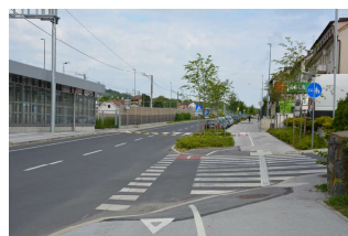
Slika 19: Izvedeni spušteni robniki v naselju Šentilj, ki zagotavljajo udobnejšo uporabo tako za kolesarje kot za osebe na invalidskih vozičkih
